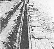
溝はすっかりきれいになり、ふたを閉めて終了です。
