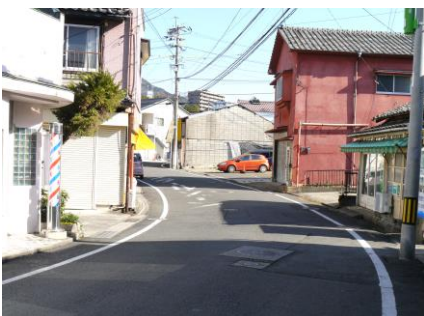
④ 横断歩道がない
